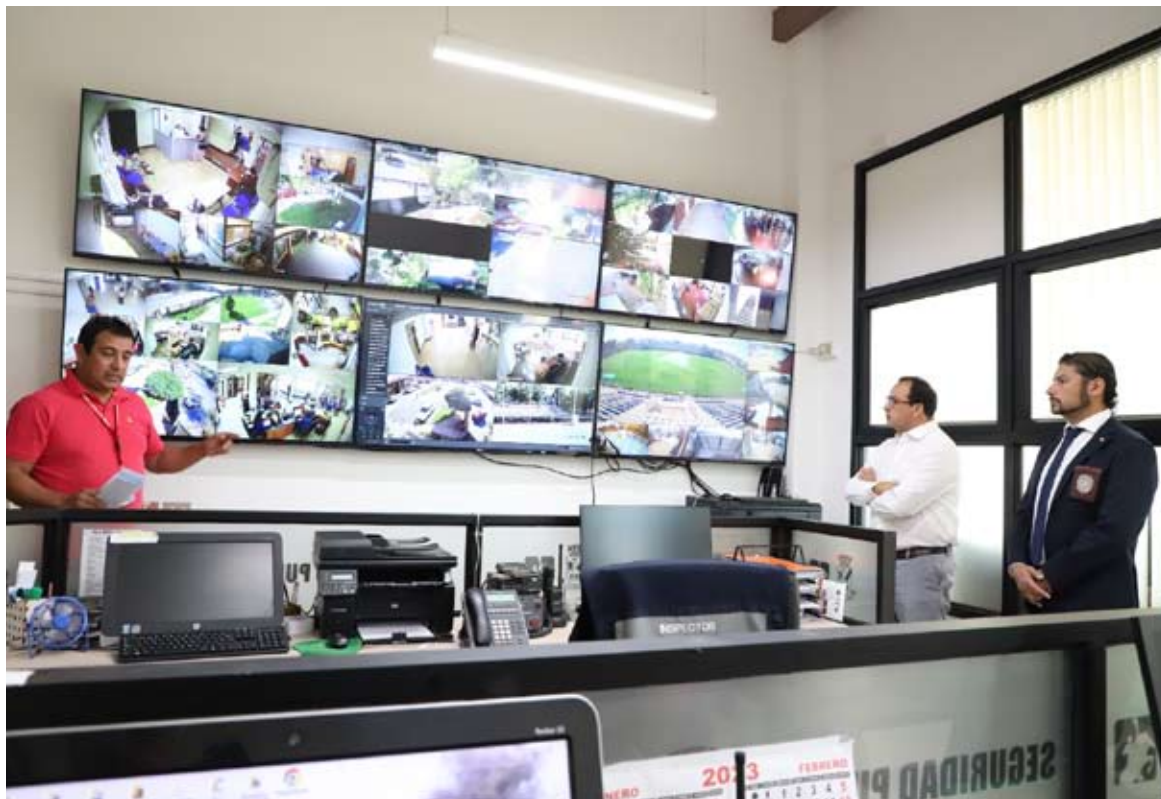
Control se realizará desde la oficina del Departamento de Seguridad Pública.
