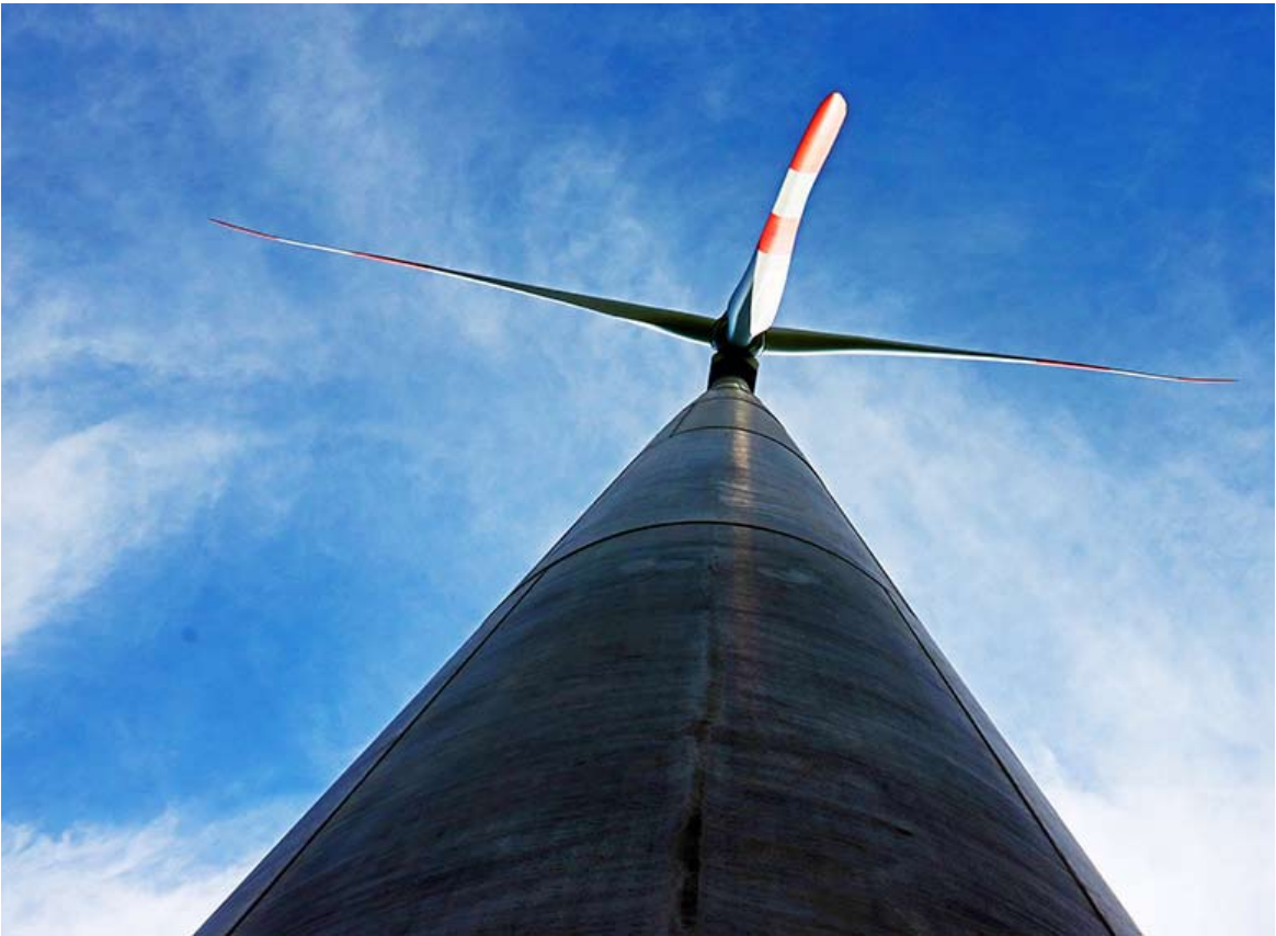
Las 27 torres que sostendrán los aerogeneradores tendrán una altura de 155 metros, sin considerar las aspas.
